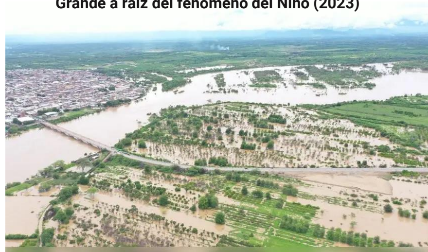
Desborde del Río Piura e inundación de Tambo Grande a raíz del fenómeno del Niño (2023)
